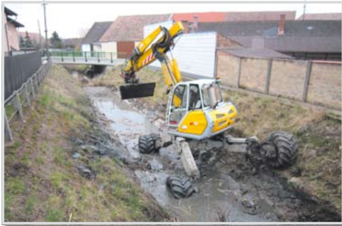
Räumung des Scherunsengrabens in Bullendorf
