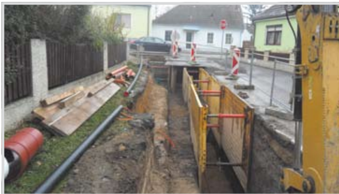
Ende Oktober wurde mit den Bauarbeiten für die Ver- und Entsorgungsleitungen begonnen, die bis Jahresende abgeschlossen sein sollen.
