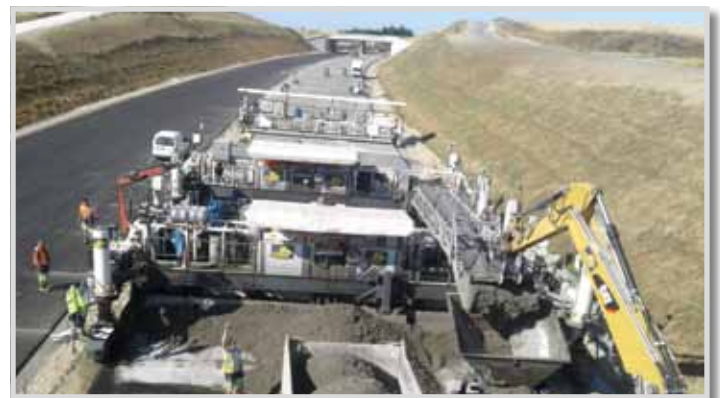
Fertigungsmaschine für die Betonfahrbahn auf der Autobahn im Einsatz. Täglich wurden ca. 600 lfm. errichtet.
