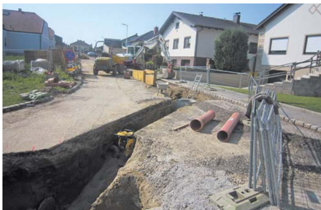
Die Sanierung und Erneuerung des Mischwasserkanals in der Brunnen- und Hubertusgasse gehen zügig voran.
