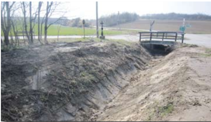
Im April wurden entlang der Zaya in Ebersdorf Uferbruchsaniierungsarbeiten von den Mitarbeitern des Zaya-Wasserverbandes durchgeführt. Foto: © Marktgemeinde Wilfersdorf
